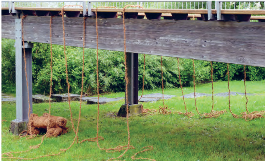
Die Hauptstränge müssen sicher an der Brücke befestigt werden.
