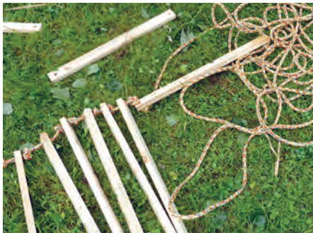
Das selbstgedrehte Seil aus Recyclingschnüren kommt später bei der Seilbrücke zum Einsatz.
