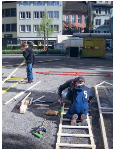
Mithilfe von Lehren können Leitern selbständig hergestellt werden.
