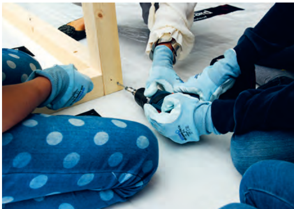
Selbständiger Aufbau der Trägerstruktur mit Akkuboherer.
